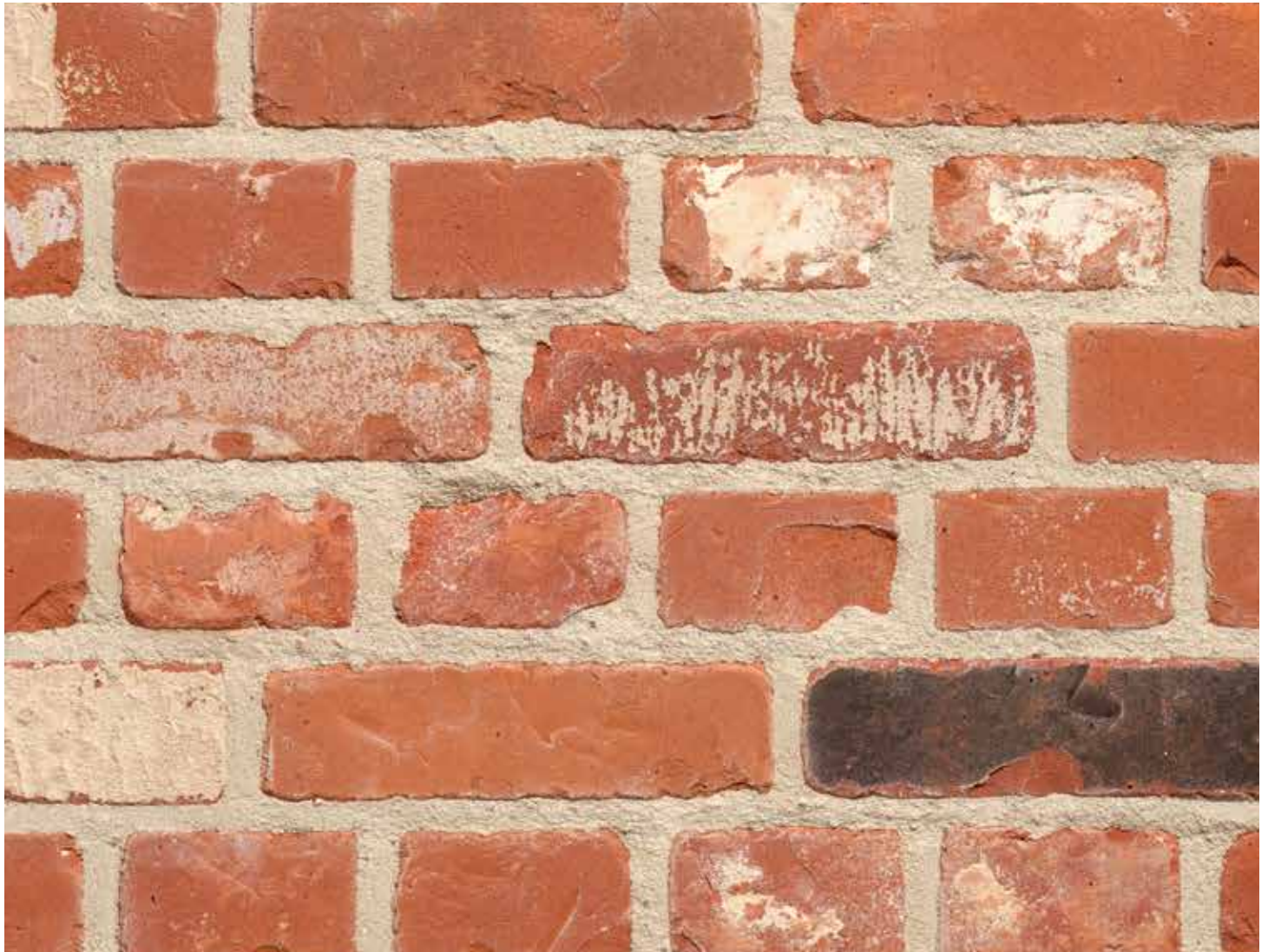
Schijnvoeg / Faux joint
